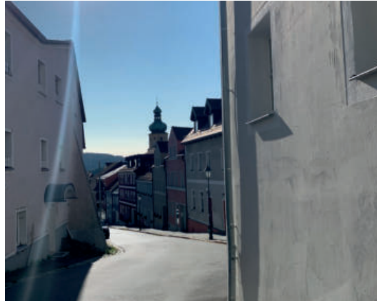
GESCHLOSSENE HÄUSERFRONT, HISTORISCHE STRUKTUR ERHALTEN
