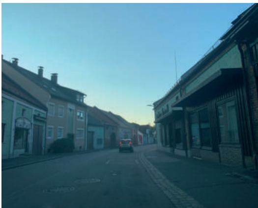
ÜBERFORMUNGEN SOWIE UNRUHIGE UND UNEINHEITLICHE FASSADENGESTALTUNG
