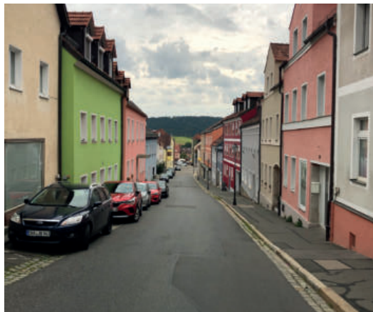
EINSEITIGER GEHSTEIG ODER DURCH PARKPLATZE FUSSWEG NICHT NUTZBAR, KEINE BARRIEREFREIEN QUERUNGEN
