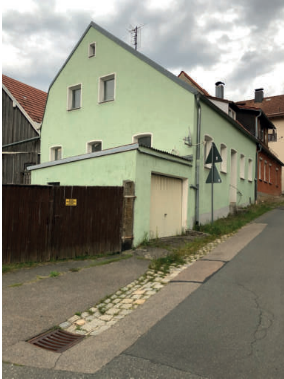
FOTO 1/2/3 ORTSBEGEHUNG 26.07.21 BLICK IN DIE SCHULSTRASSE
