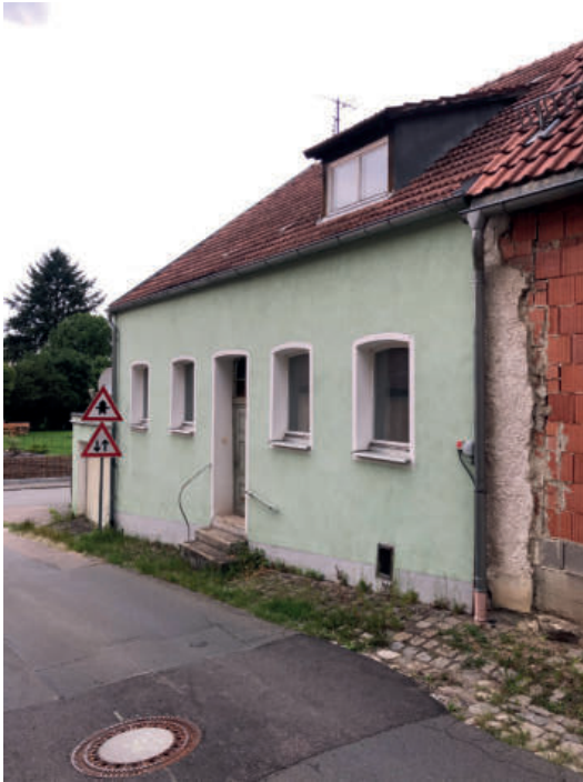
SCHULSTRASSE 37 ZUM ABBRUCH STEHENDES GEBÄUDE
