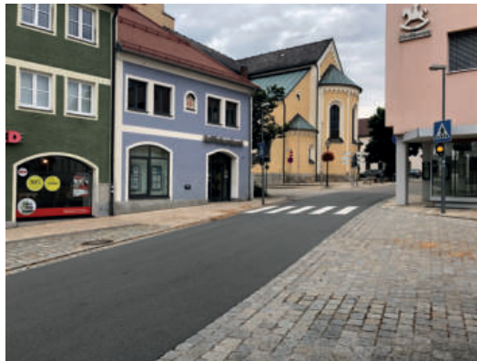
PFLASTERBELAG MIT GEBROCHENEM PFLASTERSTEIN MIT GROSSEN FUGEN ALS HINDERNIS FÜR ROLLSTUHLFAHRER
